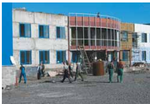
СТРОИТЕЛЬСТВО «БИАКСПЛЕН К», 2004 ГОД
