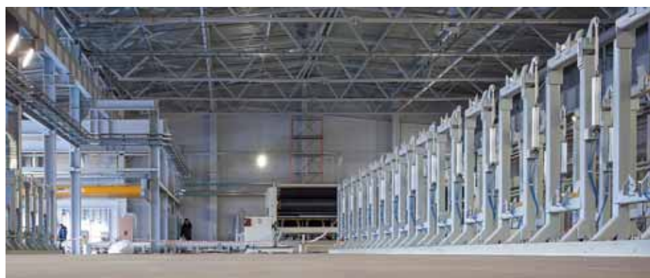
СТЕЛЛАЖИ ДЛЯ ХРАНЕНИЯ ГИГАНТ-РУЛОНОВ НА СТРОЯЩЕМСЯ ПРОИЗВОДСТВЕ БОПП-2 В Г. НОВОКУЙБЫШЕВСКЕ
